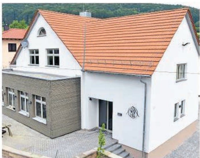
Das Dachgeschoss wurde entkernt, links entstand ein neuer Anbau für die Feuerwehr. Fotos: Franz-Josef Enders
