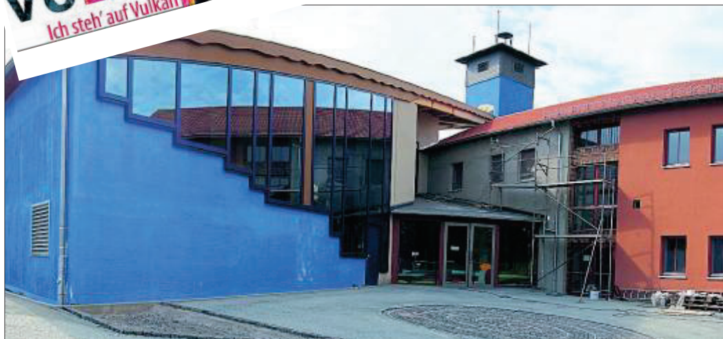
Das Vulkaneum-Gebäude kurz vor der Fertigstellung: Blau steht für das Vogelsberger Wasser und Rot für den Sandstein des überbauten ehemaligen Feuerwehrhauses.
