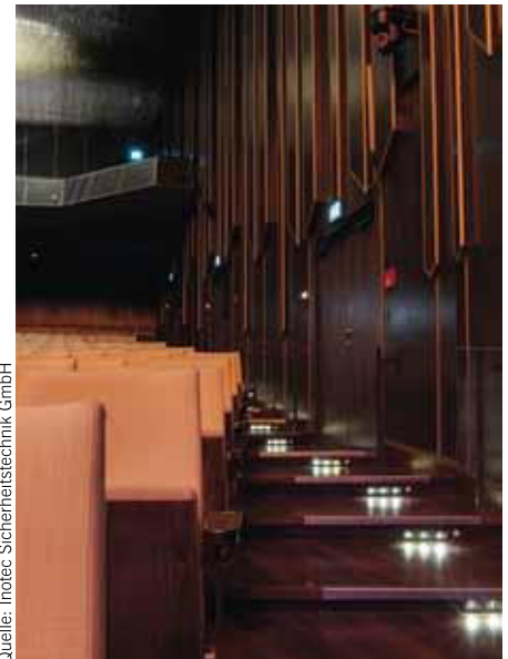
4 Dimmbare Stufenleuchten im Veranstaltungsbereich
