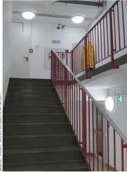
6 Allgemein- und Sicherheitsbeleuchtung in einem Gerät kombiniert
