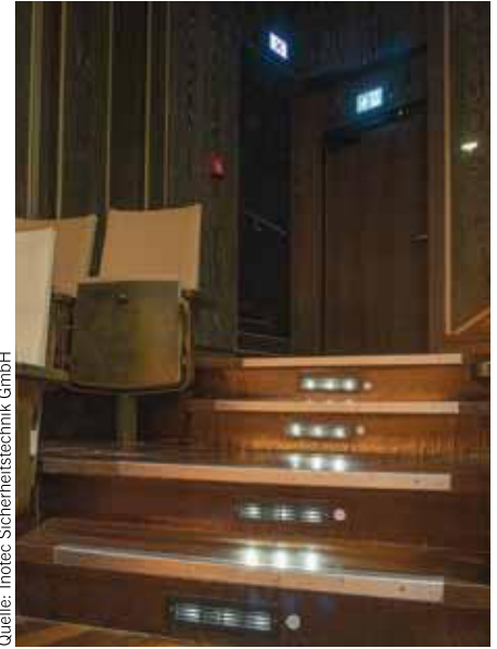
7 Fluchtwegsteuerung im oberen Rang
