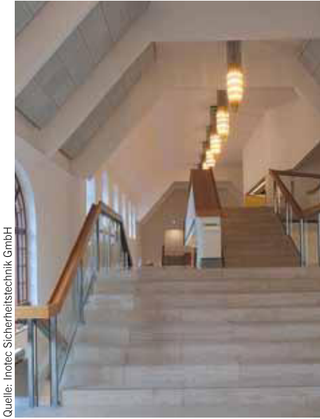
5 Im oberen Emporen-Bereich konnten die Kronleuchter in die Sicherheitsbeleuchtung integriert werden
