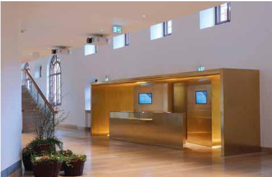
3 Regelbare TFT-Leuchten als Rettungswegkennzeichen und für die dynamische Fluchtweglenkung mit Rollstuhlkennzeichnung im Foyer
