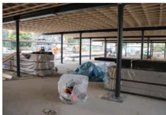
Direkt angrenzend an Gebäude für den Sanitär- und Umkleebereich ist das Dach ...
