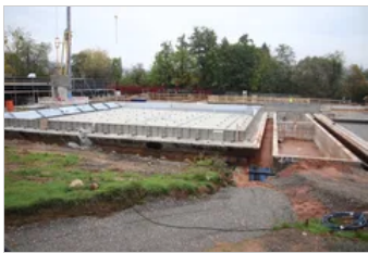
Beim Nichtschwimmer-Becken sind bereits die Edelstahl-Erhöhlungen montiert worden. ...
