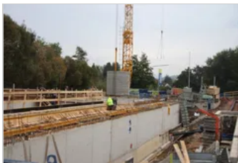
Direkt am Eingang des Freibades wird derzeit das Technikgebäude errichtet. ...
